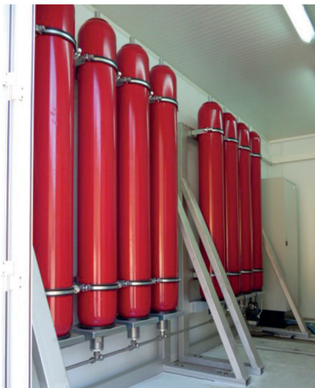
Application: réserve de secours Client: BT Hydraulik, Berne Produits ORELL utilisés: accumulateurs à vessie 8 x EHV 50
