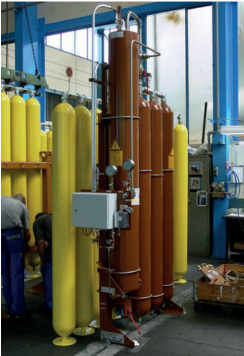
Application: réserve d'énergie pour la régulation de turbines Francis, Centrale Sisteron France Client: Andritz Hydro AG, Kriens Produits ORELL utilisés: station d'accumulation à piston ORELL / BSD
